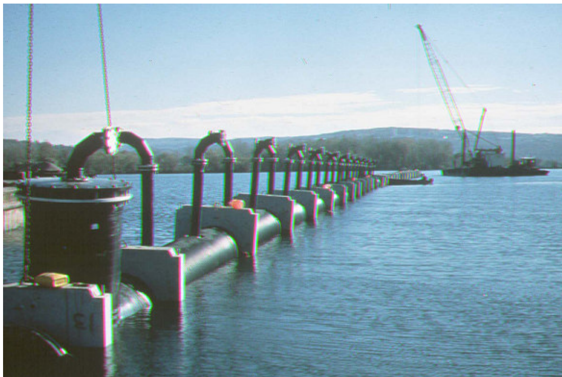
Εικόνα 24: Πόντιση αγωγού διάθεσης υγρών αποβλήτων στη θάλασσα
