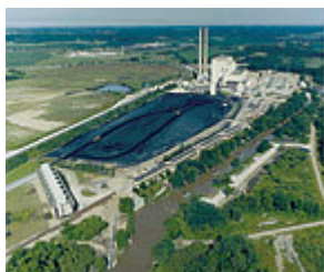
Εικόνα 7. Αυτή η φωτογραφία δείχνει ένα υλοποιημένο σχέδιο αποφυγής θερμικής ρύπανσης στις εγκαταστάσεις Cinergy Corporation. Η εταιρία αρχικά σχεδίαζε να νοικιάσει ένα πύργο ψύξης αλλά τελικά αποφάσισε να αγοράσει 60 μικρές μονάδες πύργων ψύξης με τη λογική ότι οι μονάδες μπορούν αργότερα να μεταφερθούν σε άλλες περιοχές για να λύσουν άλλα περιστασιακά προβλήματα θερμικής ρύπανσης. Οι αντλίες επιπλέον σε πλωτήρες κατά μήκος του ποταμού, και ένας μεγάλος συμβατικός πύργος ψύξης φαίνεται στο βάθος αριστερά.
