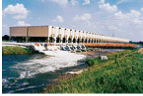
Εικόνα 8. Το εργοστάσιο Commonwealth Edison χρησιμοποίησε προσωρινούς πύργους ψύξης για να μειώσει την θερμοκρασία του καναλιού εκροής πριν το νερό φτάσει σε γειτονικό ποταμό.
