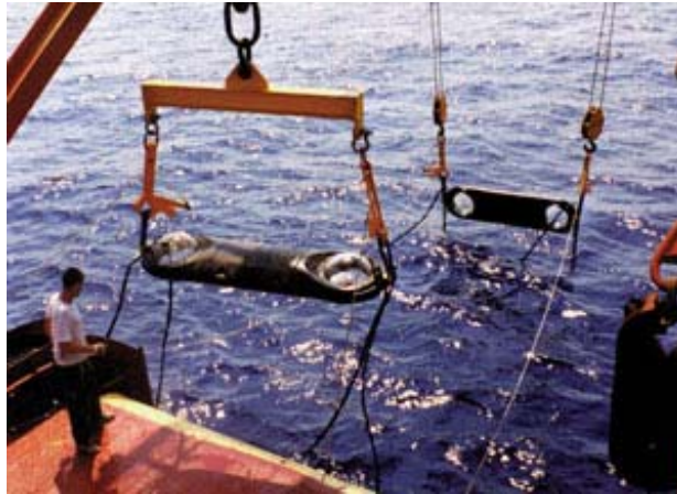
Εικόνα 3: Καταβύθιση μονάδος του υποθαλασσίου τηλεσκοπίου νετρίνων ANTARES, Νότιος Γαλλία
