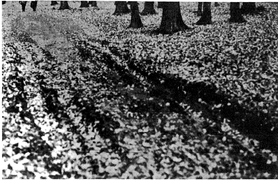
Φωτ. 1α. Δασικός δρόμος στην περιοχή Sauerland της Αγγλίας πριν τη σταθεροποίησή του με το υλικό RRP - 235. (Schwarz VBI. 1978)
