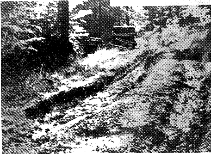
Φωτ. 2α. Δασικός δρόμος στη δασική περιοχή Meissner πριν τη σταθεροποίηση με το υλικό RRP - 235 (Schwarz VBI. 1978)
