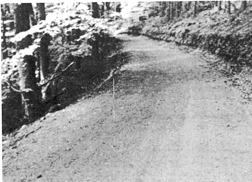
Φωτ. 2β. Ο ίδιος δασικός δρόμος μετά τη σταθεροποίησή του με RRP - 235 (Schwarz VBI. 1978)
