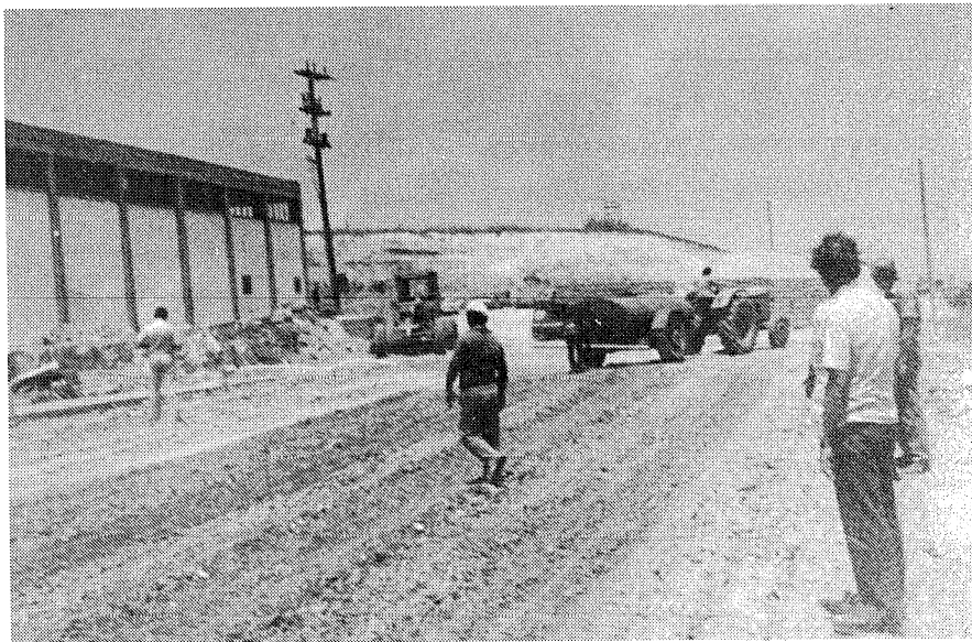
Φωτ. 3. Επαρχιακός δρόμος στην Πορταριά Χαλκιδικής κατά το στάδιο της κατεργασίας του εδαφικού υλικού RRP - 235 (φωτ. Εσκίογλου)
