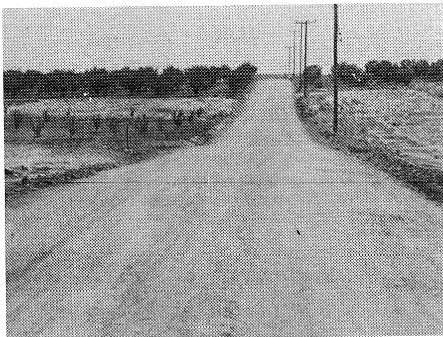
Φωτ. 3. Επαρχιακός δρόμος στην Πορταριά Χαλκιδικής κατά το στάδιο της κατεργασίας του εδαφικού υλικού RRP - 235 (φωτ. Εσκίογλου)
