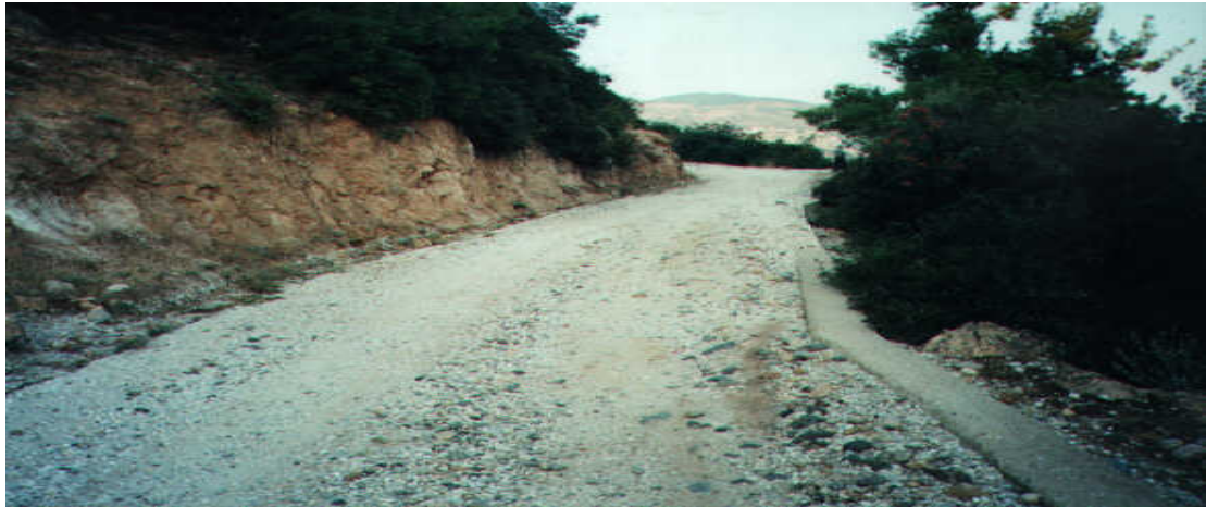
Φωτογραφία 4 .Δασικός δρόμος σταθεροποιημένος με υπολείμματα μαρμάρου
