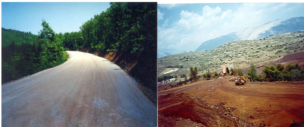
Φωτογραφία 2,3 Δρόμος σταθεροποιημένος με ιπτάμενη τέφρα και ερυθρά ιλύ
