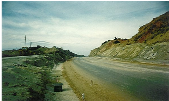
Φωτογραφία 5,6. Τρίμματα ελαστικών και σταθεροποιημένος με αυτά δρόμος
