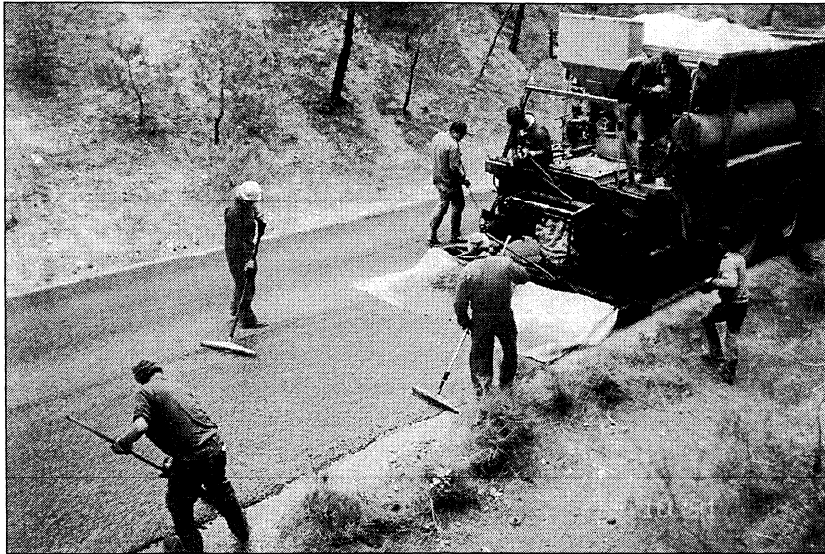
Φωτογραφία 2. Τρόπος διάστρωσης αντιολισθηρού τάπητα στο δασικό δρόμο Κομοτηνής - Νυμφαίας.
