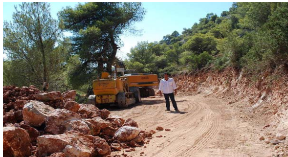
Εικόνα 1. Μηχανήματα μικρού όγκου για διάνοιξη δασικού δρόμου ( http://www.voreini.gr )
