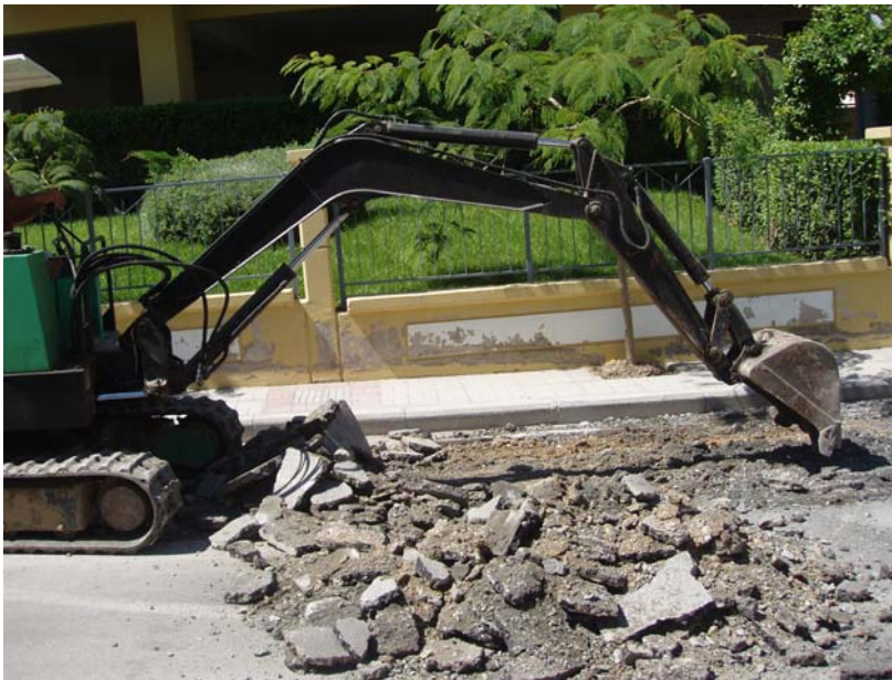
Εικόνα 2.Εργασίες ανακατασκευής οδοστρώματος
