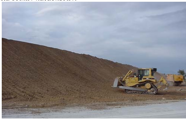
Φωτογραφία 4. Κατασκευή οδικού επιχώματος με Ιπτάμενη Τέφρα Photo 4. Construction of embankment with Fly ash
