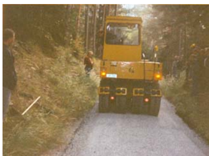
Φωτογραφία 3. Ανάμειξη, διάστρωση συμύκνωση εδαφών με I.T. Photo 3. Mixture, condensation, compaction of grounds with Fly Ash
