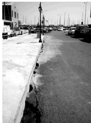
Σχήμα 7δ. Λευκάδα-μαρίνα: Ανάδυση λεπτόκοκκου υλικού
