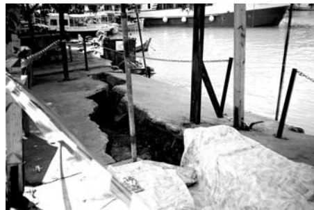
Σχήμα 6β. Βασιλική: Βύθιση και στροφή του κρηπιδώματος
