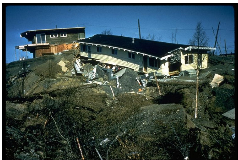
Εικόνα 1-2. Αστοχία κατασκευής λόγω εδαφική ροής στο Anchorage, (Σεισμική δόνηση μεγέθους Mw 9.2 στην Αλάσκα, Η.Π.Α το 1964)
