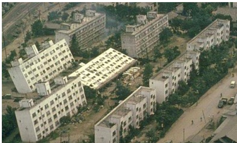
Εικόνα 1-1. Ανατροπή πολυκατοικιών λόγω ρευστοποίησης των υποκείμενων εδαφικών σχηματισμών (Σεισμική δόνηση μεγέθους Ms 7.5 στην Niigata, Ιαπωνία, το 1964).
