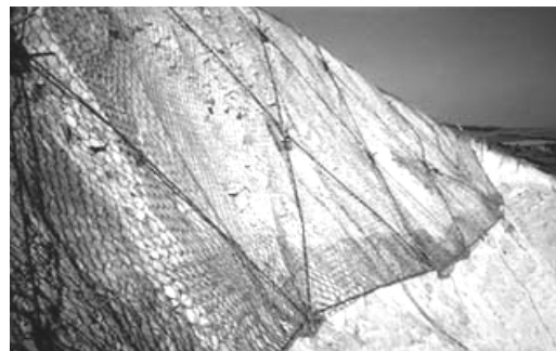
Σχήμα 10. Μεταλλικό πλέγμα για τη συγκράτηση μικρών τεμαχίων (www.alpideco.it)
