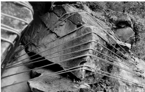
Σχήμα 9. Ενδεικτική θέση με συρματόσχοινα αυξημένης αντοχής (www.alpideco.it)
