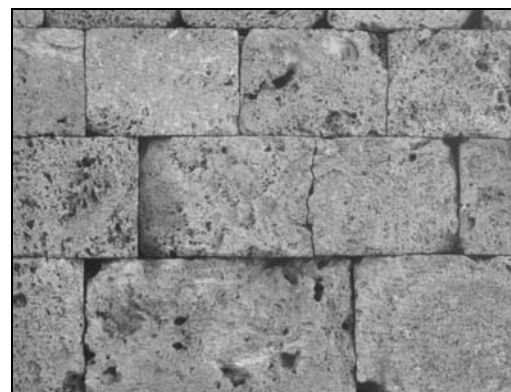
Εικόνα 2. Λεπτομέρειες της τοιχοποιίας του τάφου (δομικό υλικό: τραβερτίνης) Figure 2. Details from the wall of the tombs (structured material: travertine)
