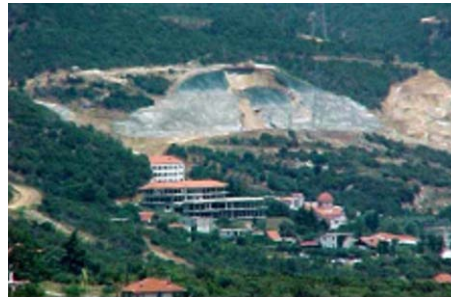
Figure 15. Un grand glissement de terrain, étudié
