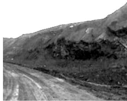
Figure 3. Pente placée à la droite de la route
