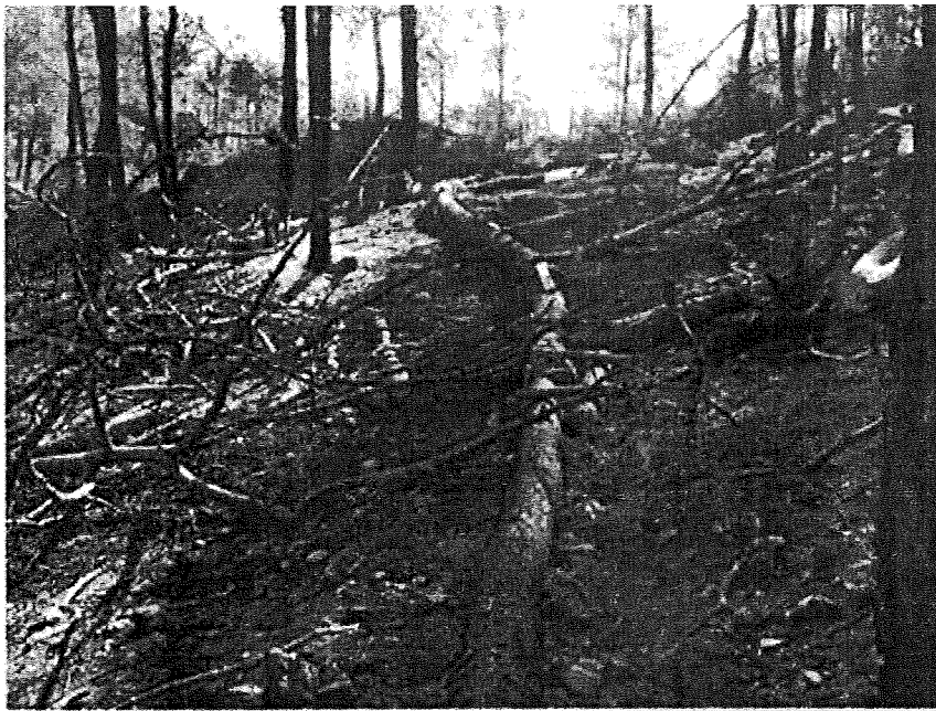
Εικόνα 1: Κατασκευή κορμοδεμάτων στη στην Νήσο Ρόδο
