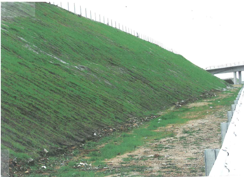
ΦΥΤΟΤΕΧΝΙΚΗ ΔΙΕΥΘΕΤΗΣΗ ΑΥΛΑΚΩΤΩΝ ΔΙΑΒΡΩΣΕΩΝ
