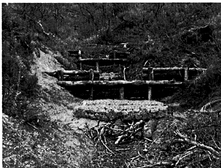
Εικόνα 4: Ξυλοφράγματα στην περιοχή της Κασσάνδρας με "ποδιά" από συρματόπλεχτα κιβώτια (σαραζανέτ)
